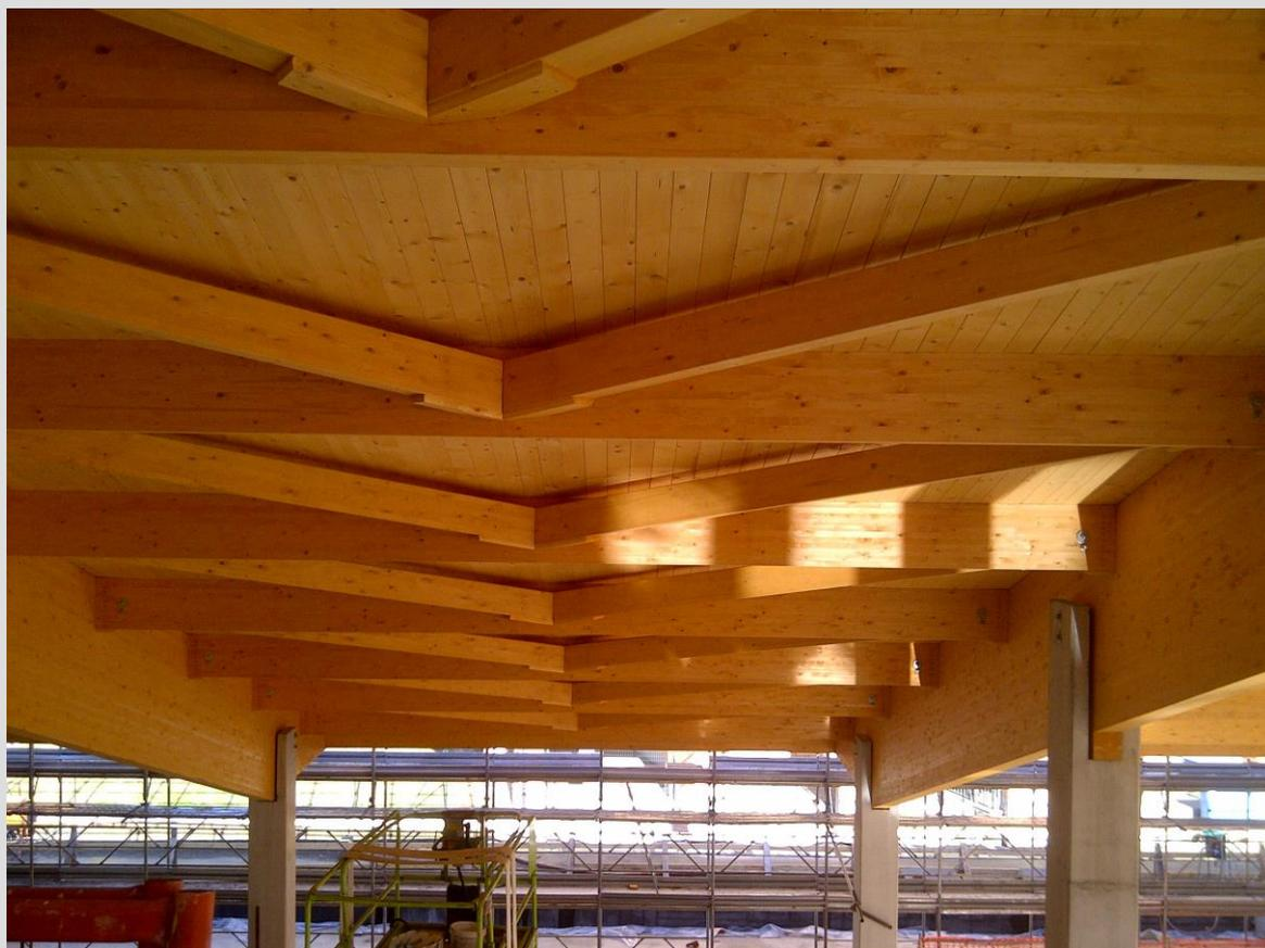
**Non occorre più sovradimensionare le strutture di legno lamellare utilizzando la velocità di carbonizzazione di 0,7 mm/min prevista dagli Eurocodici.**
